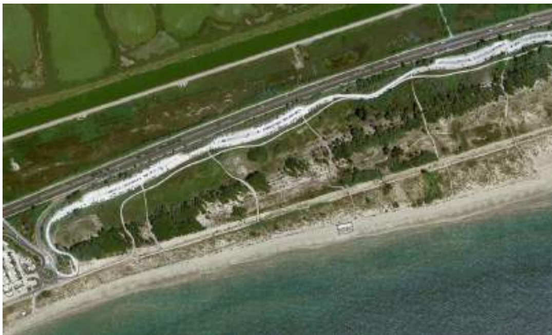
15 - Le Petit Travers - Photo après travaux (Projet ADAPTO)
