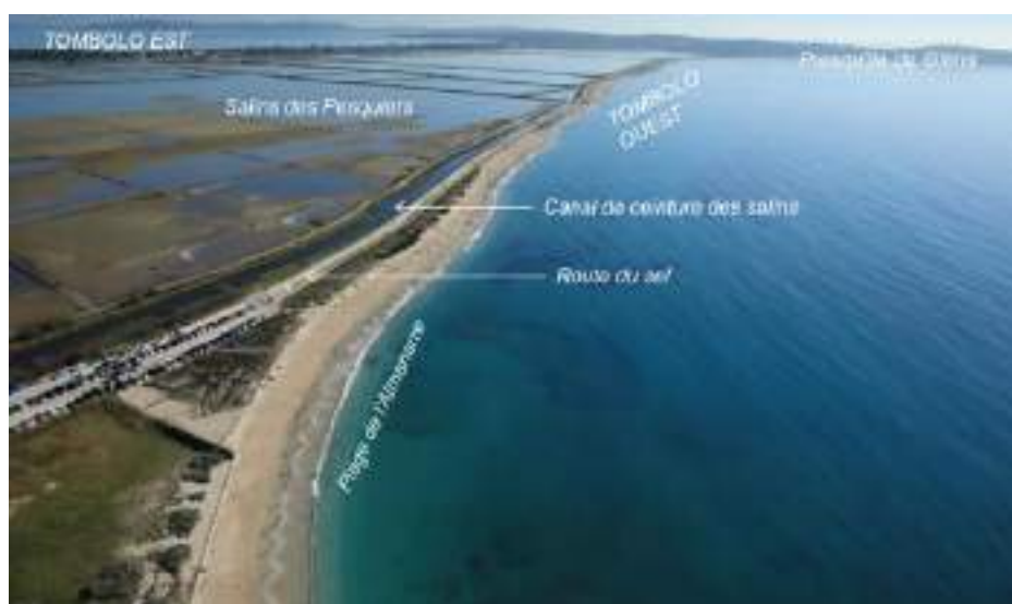
9 - Vue aérienne du site - Etude ARTELIA « Définition de travaux pour la protection du tombolo ouest et de la route du sel » - Octobre 2017
